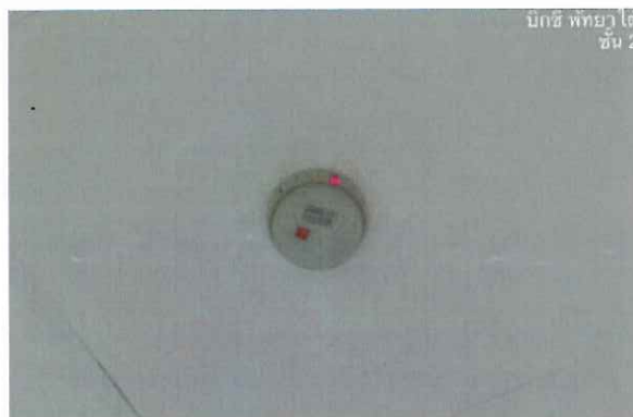
รูปที่ 1.5 Heat detector
