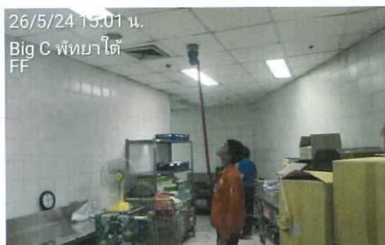
รูปที่ 2.38 ทดสอบ Heat Detector พื้นที่บริเวณเฟรสฟู้ด
