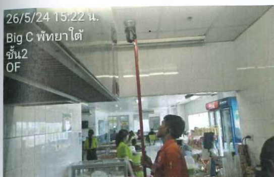
รูปที่ 2.37 ทดสอบ Heat Detector พื้นที่บริเวณห้องแคנתิน
