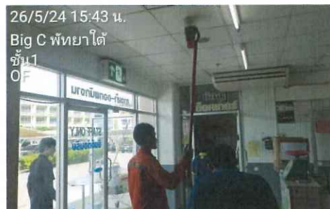
รูปที่ 2.18 ทดสอบ Smoke Detector พื้นที่บริเวณทางเข้า-ออกพนักงาน
