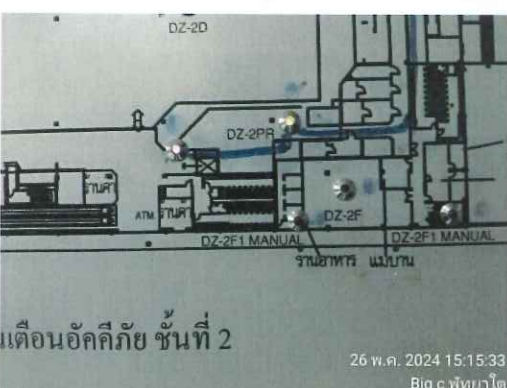
รูปที่ 2.87 ตู้ควบคุม และตู้กราฟฟิกแสดงผลแจ้งเหตุเพลิงไหม้ zone 09(DZ-2PR)
