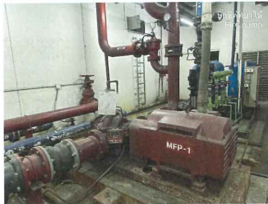
รูปที่ 2.1 ตรวจสอบและทำความสะอาดเครื่องสูบน้ำดับเพลิง
