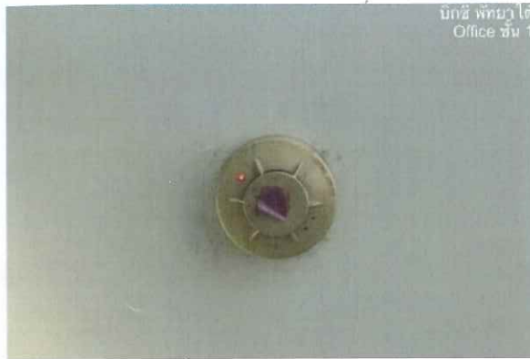
รูปที่ 1.4 Smoke detector
