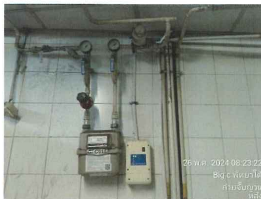
รูปที่ 2.116 ทดสอบ Gas controller และ Shut off valve พื้นที่ร้านก๋วยจั๊บญวน หลัง
