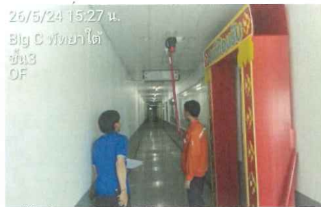
รูปที่ 2.16 ทดสอบ Smoke Detector พื้นที่บริเวณทางเดินสำนักงาน
