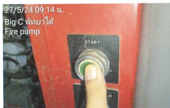
รูปที่ 2.3 ทดสอบการทำงานของเครื่องสูบน้ำดับเพลิงโดยการ start ผ่านตู้ควบคุม
