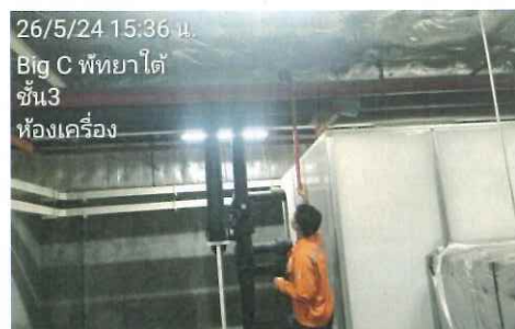
รูปที่ 2.18 ทดสอบ Smoke Detector พื้นที่บริเวณทางเข้า-ออกพนักงาน
