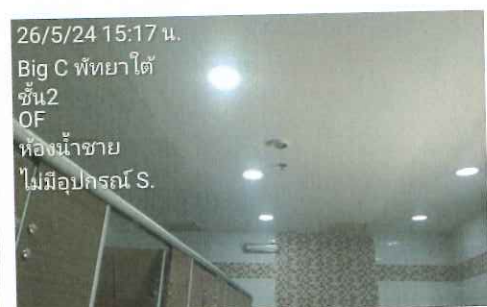
รูปที่ 3.6 ไม่มีอุปกรณ์ Smoke detector
