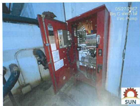
รูปที่ 2.2 ตรวจสอบและทำความสะอาดตู้ควบคุมของเครื่องสูบน้ำดับเพลิง
