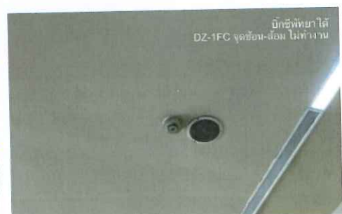
รูปที่ 3.6 ไม่มีอุปกรณ์ Smoke detector
