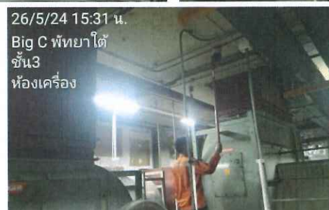
รูปที่ 2.19 ทดสอบ Smoke Detector พื้นที่บริเวณห้องเครื่อง
