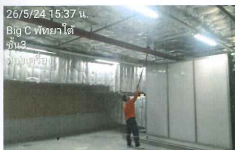
รูปที่ 2.18 ทดสอบ Smoke Detector พื้นที่บริเวณทางเข้า-ออกพนักงาน
