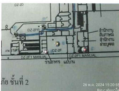
รูปที่ 2.85 ตู้ควบคุม และตู้กราฟฟิกแสดงผลแจ้งเหตุเพลิงไหม้ zone 07 (DZ-2F)
