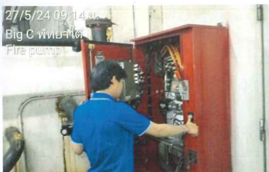
รูปที่ 2.3 ทดสอบการทำงานของเครื่องสูบน้ำดับเพลิงโดยการ start ผ่านตู้ควบคุม
