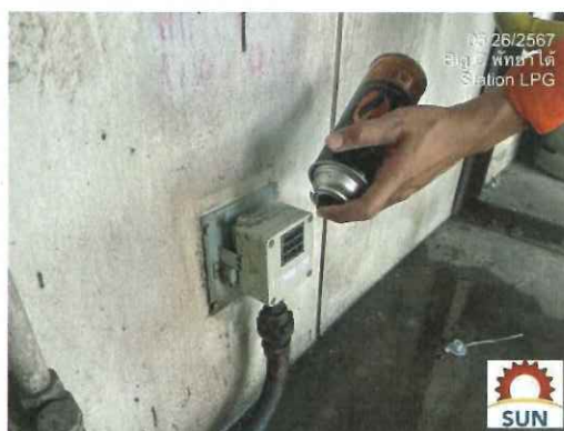
รูปที่ 2.118 ทำความสะอาด Gas detector และ Gas controller พื้นที่ LPG Station
