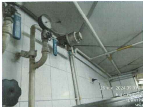
รูปที่ 2.102 ทดสอบ Gas controller และ Shut off valve พื้นที่ร้านเย็นตาโฟ หน้า
